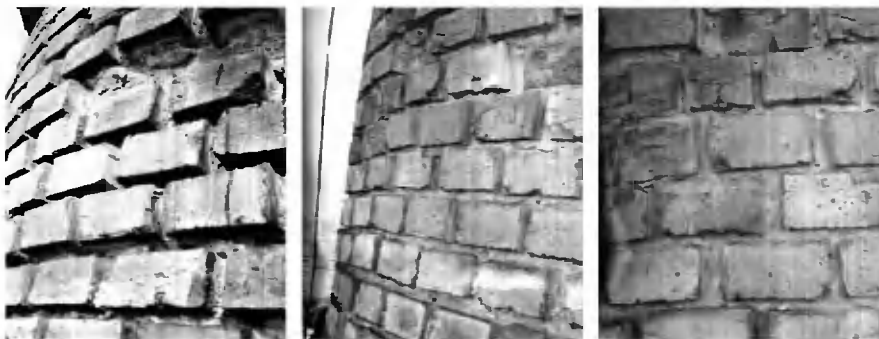
Рис. 2.97. Выкрашивание кирпича
